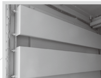
エアコン取付スペース
