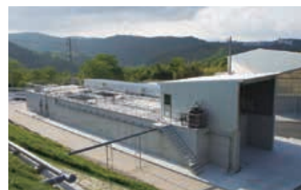
■ 佐賀 豚舎污水排水処理施設
