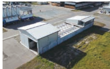
■ 島根 パーラー排水処理施設
