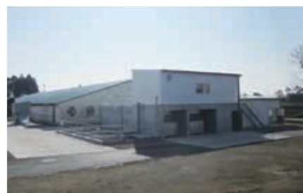
■ 宮崎 豚舎污水排水処理施設
