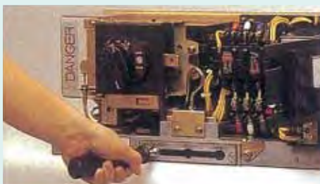
ロックカラーを完全に押し込み 断路位置の機械的ロックを解除
