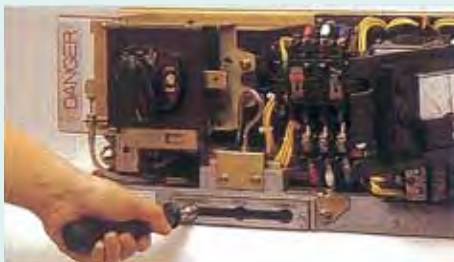
断路位置 操作レバーセット状態
