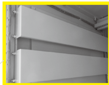
エアコン取付スペース
