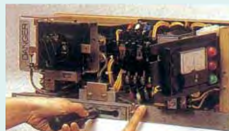
操作レバーストッパーを押し上げて 右側へ移動
