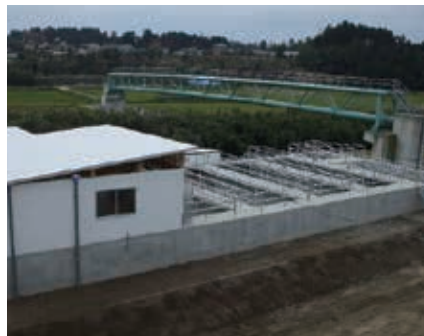
■ 宮崎県 母豚500頭一貫 污水处理施設
