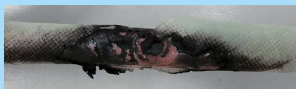
【ケーブル解体】
