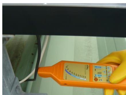
《モジュール間配線探査》
