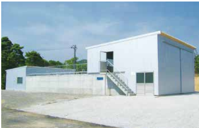
■ 1,000頭 パーラー排水処理施設
