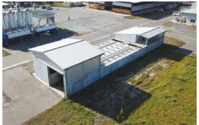
■ 1,200頭 パーラー排水処理施設
