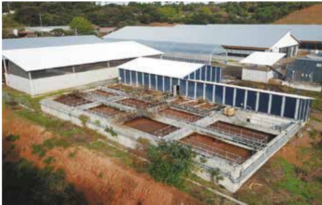
■ 700頭 メタン発酵消化液汚水処理施設
