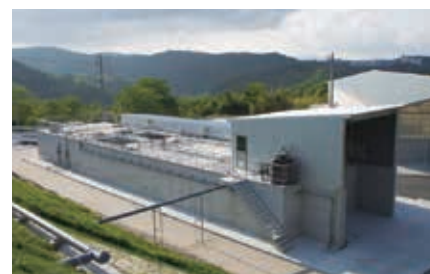
■ 佐賀 豚舎污水排水処理施設
