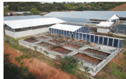
■ 鳥取 メタン発酵消化液污水处理施設
