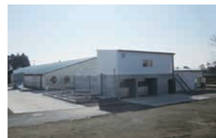
■ 宮崎 豚舎污水排水処理施設
