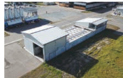
■ 島根 パーラー排水処理施設
