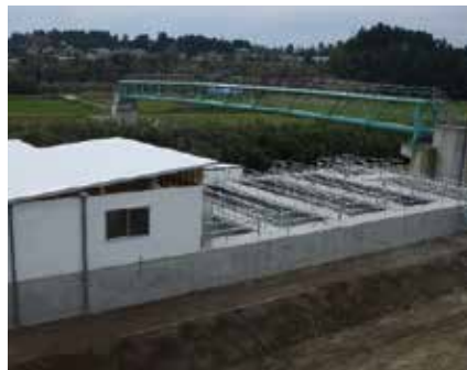
■ 宮崎県 母豚500頭一貫 污水处理施設
