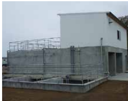
■ 宮崎県 母豚750頭 污水处理施設
