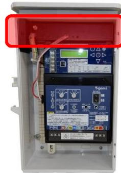
地絡波形収集装置を組み込んだ
