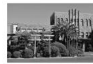
写真1 本社管理棟(木造3階建)
