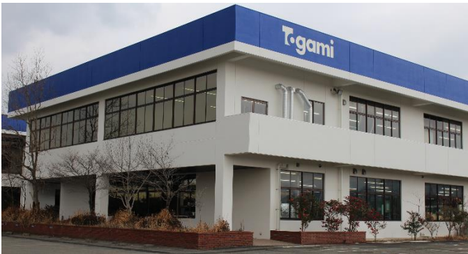
(株式会社戸上コントロール本社・第一工場)
