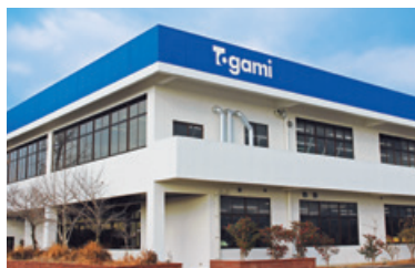
戸上コントロール本社・第一工場
