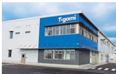
戸上コントロール第二工場
