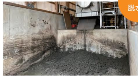
最初沈殿汚泥と余剰汚泥を混合させ、脱水機で脱水します。スクリュープレス型脱水機で低含水率の脱水ケーキとなります。
