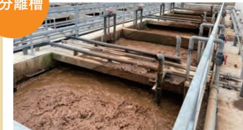
MF膜にて活性汚泥と処理水を分離し、放流槽に移送します。メンテナンス時を考慮し、膜分離槽は複数の水槽に分けて配置されています。
