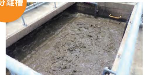
MF膜にて活性汚泥と処理水を分離し、処理水循環槽に移送します。メンテナンス時を考慮し、複数の水槽に分けて配置されています。
