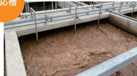
活性汚泥による生物処理を行います。脱窒素を促進させるため、間欠曝気を行います。この施設は、DO、pH、ORP計を配置し、状態の監視ができます。
