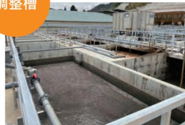
振動篩でし渣を除去した分離液を貯留します。1日分の汚水を貯留させ、濃度を均一化させます。
