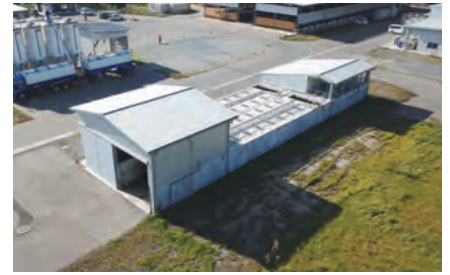
■ 島根 パーラー排水処理施設
