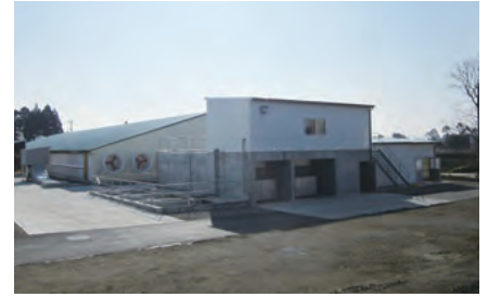
■ 宮崎 豚舎汚水排水処理施設
