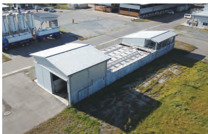
■ 1,200頭 パーラー排水処理施設
