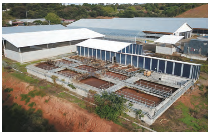
■ 700頭 メタン発酵消化液汚水処理施設
