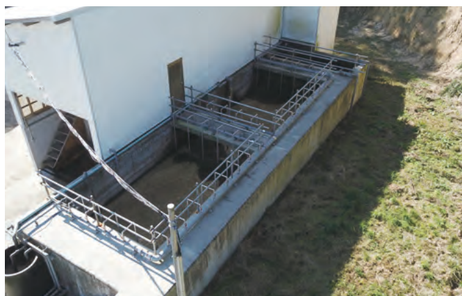
■ 300頭 スラリー汚水処理施設
