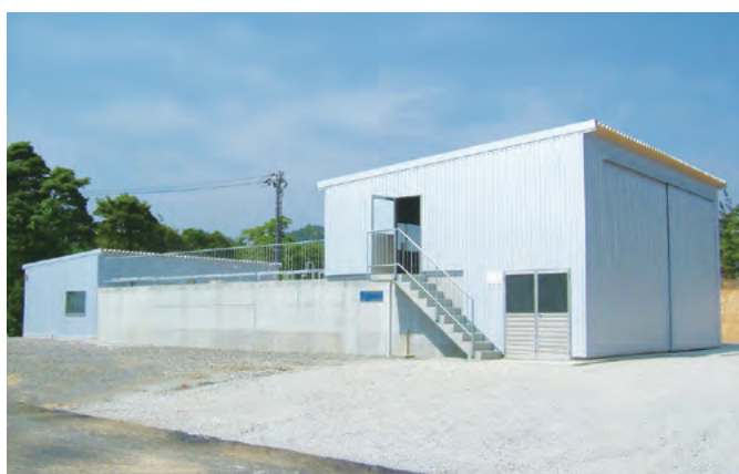
■ 1,000頭 パーラー排水処理施設
